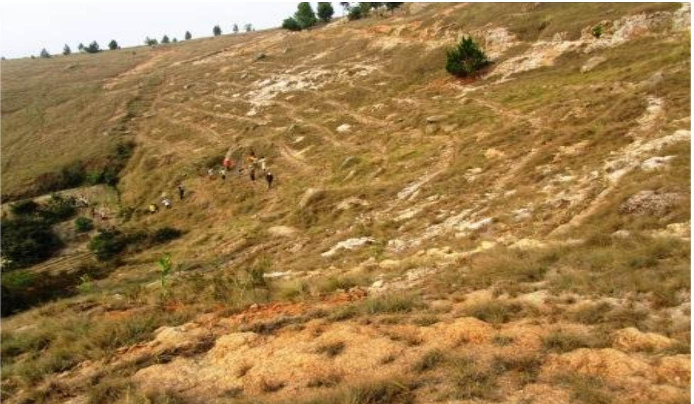
*Plantation de haies vives de Vétiver et reboisement intégré du bassin versant pilote pour la protection du captage d'eau, par la restauration du sol, la diminution du ruissellement, l'augmentation de l'infiltration des eaux de pluie dans la nappe phréatique, la conservation de l'humidité et la fixation des sédiments.*
